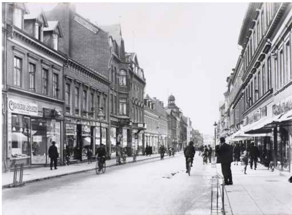
Kongensgade Esbjerg 1925. Her er det tydeligt, hvordan de store ruder i stueetagen skjuler de bærende konstruktioner og får etagen til arkitektonisk at fremstå totalt løsrevet fra resten af ejendommen. Foto: Det kongelige Bibliotek.
